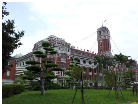
【日本統治時代に日本人の設計により建設され、現在台湾における重要文化財にも指定されている、総統府の建物】
