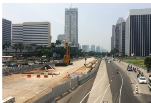
【MRT工事が進むジャカルタの大通り】
