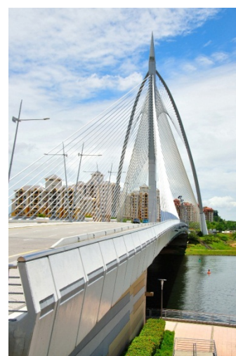
【マレーシアで最も美しい斜張橋の1つとされているスリ・ワワサン橋】
